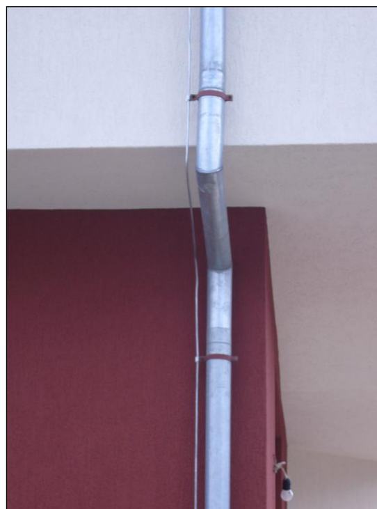
Фиг. 10. Закрепване на токоотвод върху метален водосток
