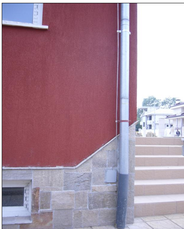
Фиг. 10. Закрепване на токоотвод върху метален водосток
