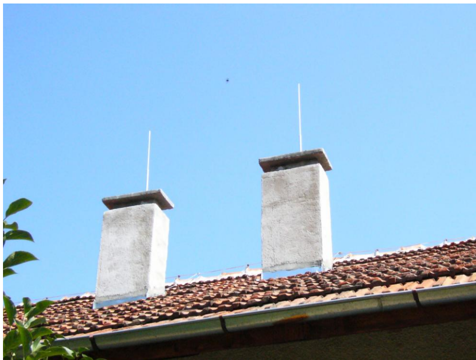
Фиг. 3. Мълниеприемен прът за комин /отдушник и т.н./
