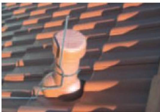
Фиг. 8. Мълниеприемен прът за отдушник
