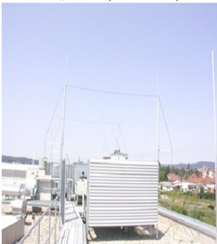
Фиг. 11. Отделни мълниеприемни системи – вариант 2
