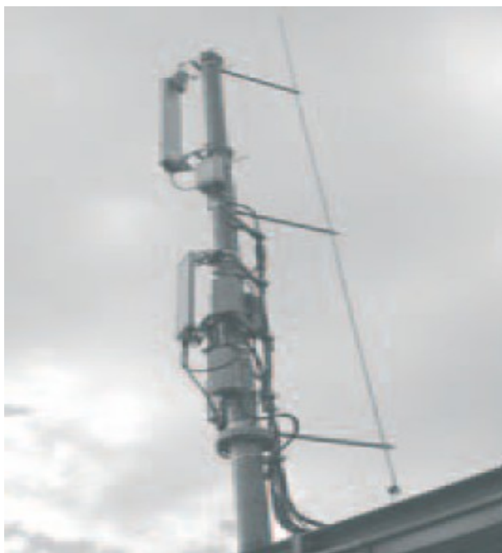
Фиг. 13. Отделни мълниеприемни системи – вариант 4
