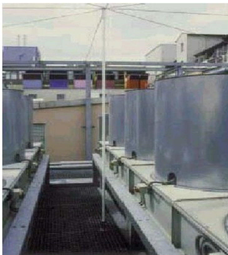
Фиг. 10. Отделни мълниеприемни системи – вариант 1
