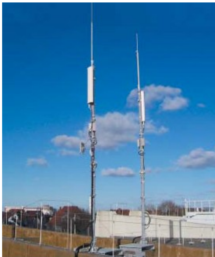
Фиг. 12. Отделни мълниеприемни системи – вариант 3
