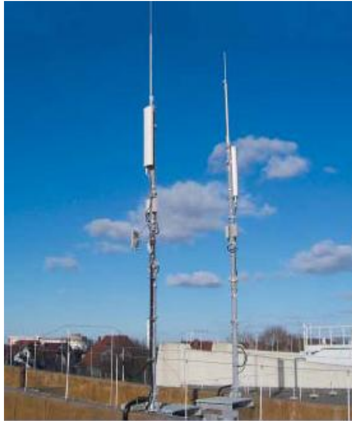
Фиг. 12. Отделни мълниеприемни системи – вариант 3
