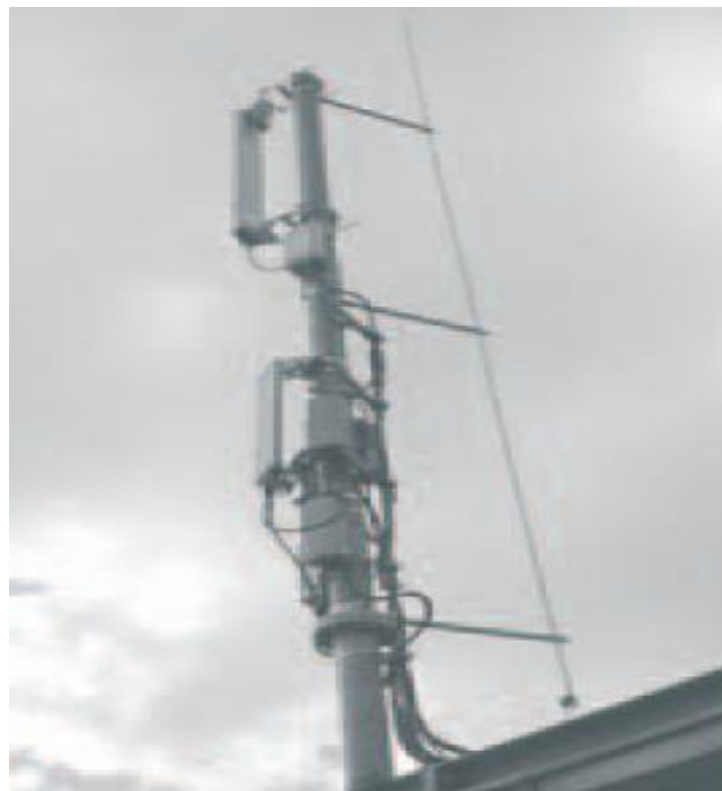
Фиг. 13. Отделни мълниеприемни системи – вариант 4
