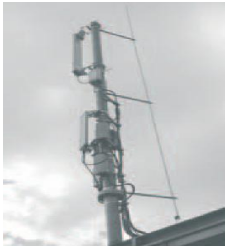
Фиг. 13. Отделни мълниеприемни системи – вариант 4
