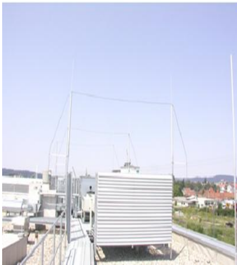
Фиг. 11. Отделни мълниеприемни системи – вариант 2
